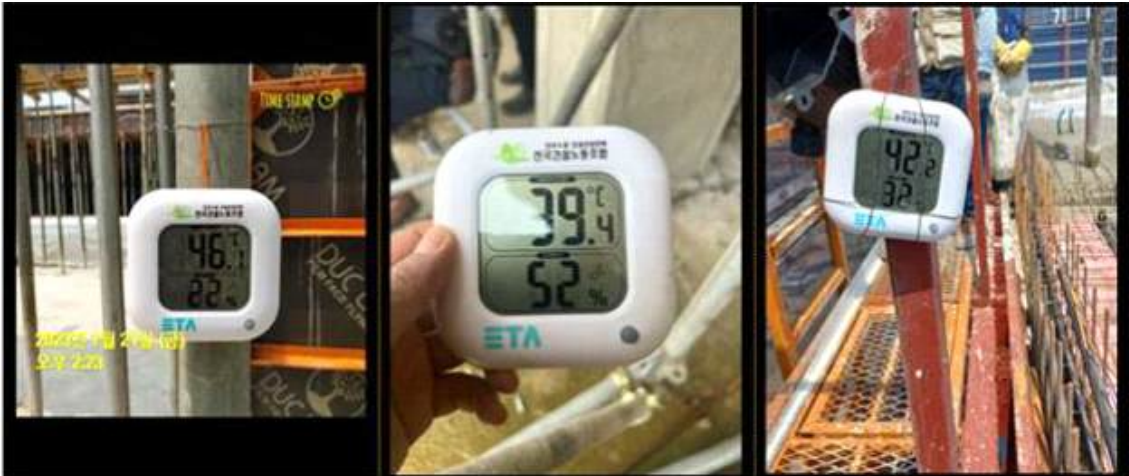
[그림6] 공사현장 실측 온도 (건설노조 보도자료, 2023.8.9.)
